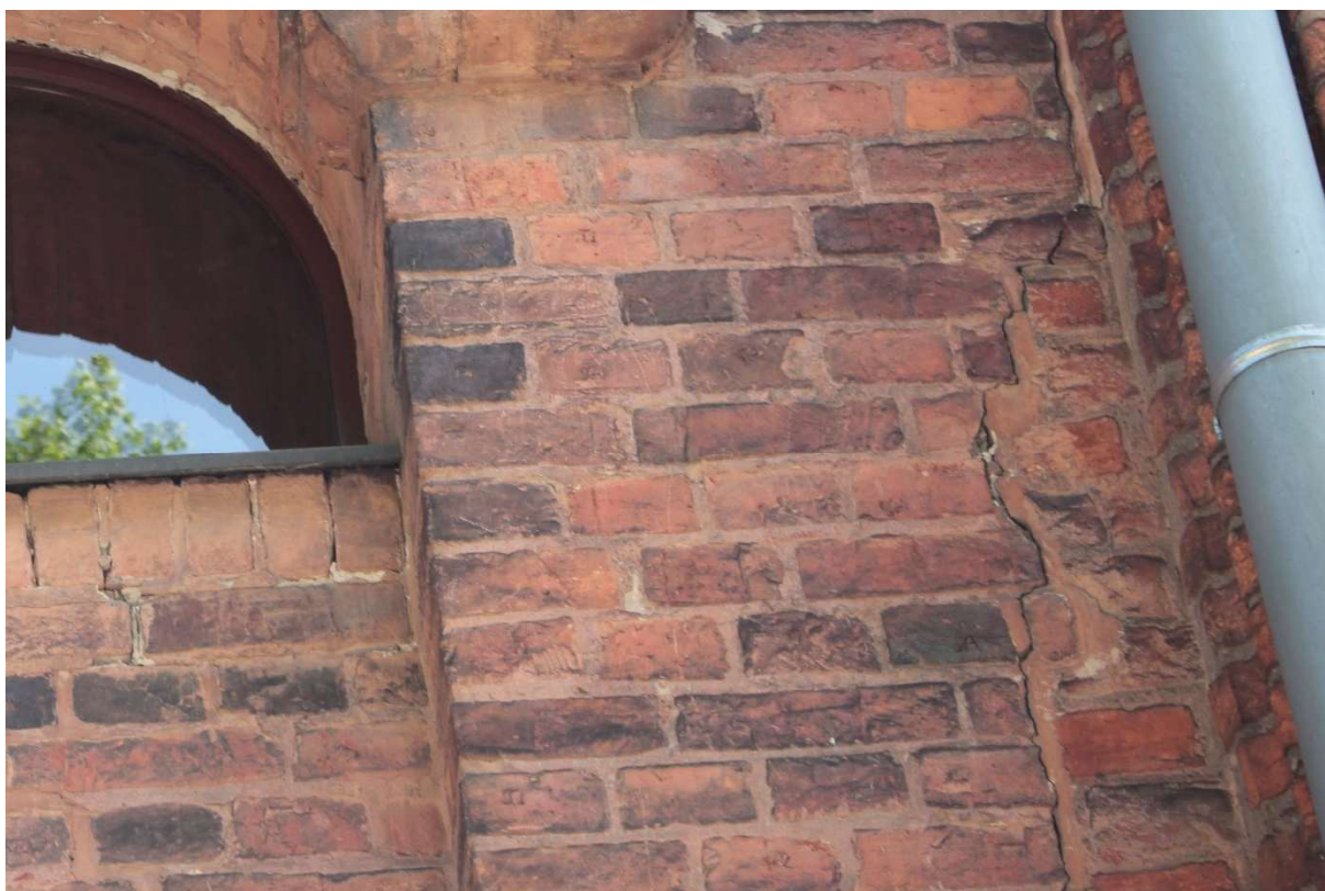
Fot.4. Dom Eskenów, Łazienna 16. Stan zachowania elewacji. Historycznym przemurowaniom towarzyszą często spękania powstające na granicy pierwotnego i wtórnego wątku.
