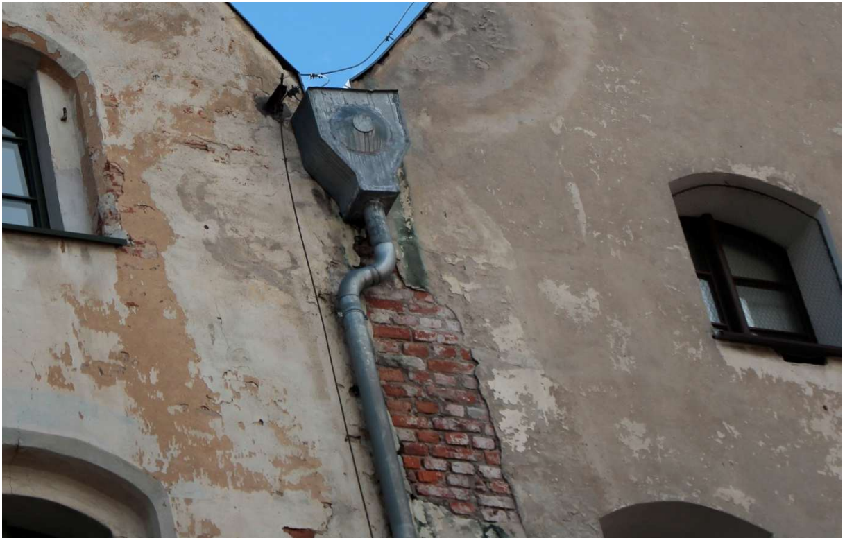
Fot.33. Dom Eskenów, ulica Ciasna 6/8. Największe zniszczenia zlokalizowane są w okolicach kosza rury spustowej.
