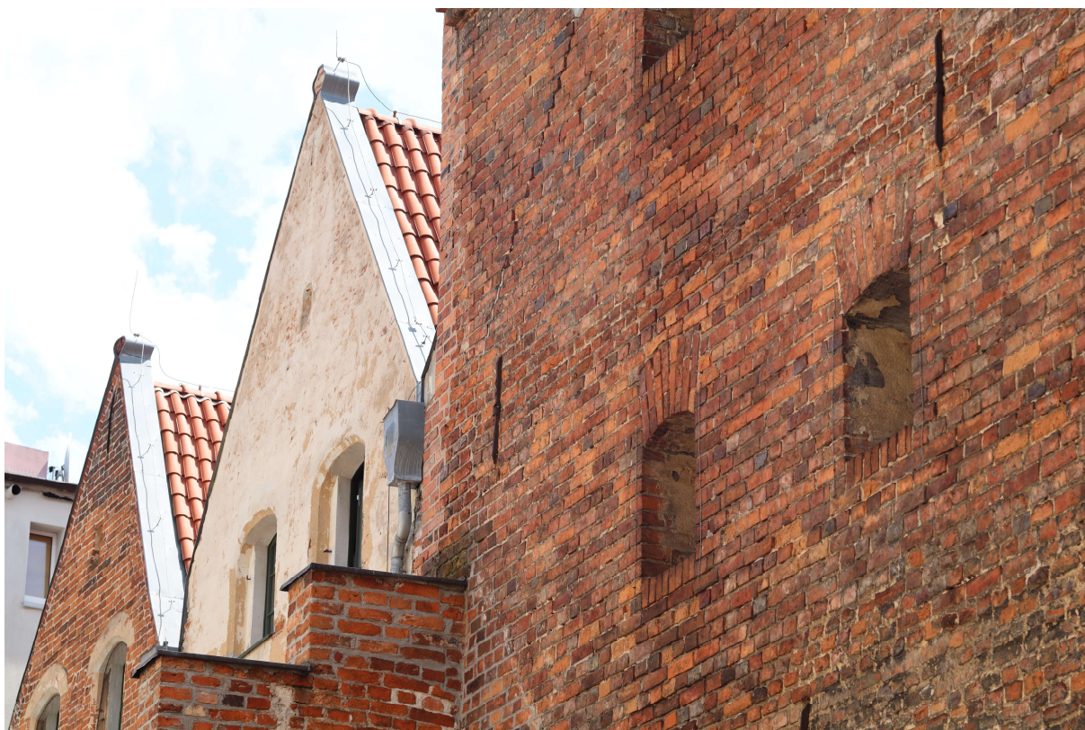
Fot.20 . Dom Eskenów, ulica Łazienna 16 widok na elewację północną. Na zdjęciu widoczne skośne spękanie statyczne zlokalizowane w lewym górnym narożniku elewacji.
