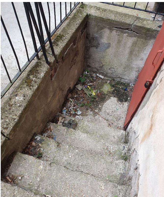
Fot.36. Dom Eskenów, ulica Ciasna 8, zejście do kotłowni. Nawet po niewielkich opadach w kesonie schodów zalega woda.
