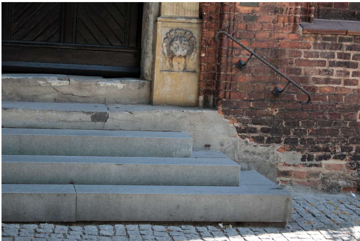
Fot.3. Dom Eskenów, Łazienna 16. Stan zachowania elewacji. W przyziemiu portalu obserwuje się szereg defektów spowodowanych zarówno warunkami ekspozycji obiektu jak i mało starannie przeprowadzonymi naprawami. Kamienny próg i pierwszy stopień portalu zatarto zaprawą cementową.
