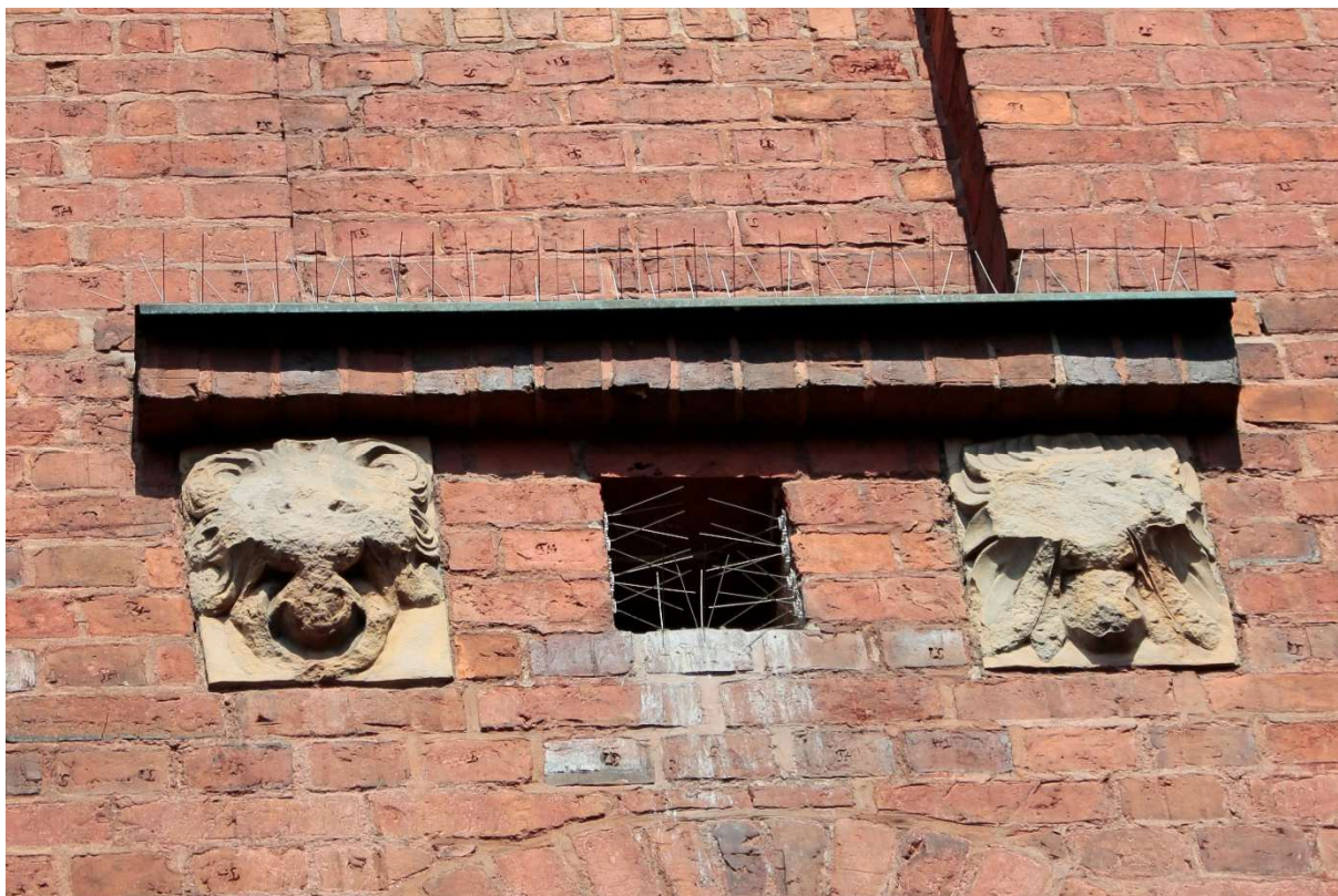
Fot.14. Dom Eskenów, ulica Ciasna, segment B. Detal kamienny zachowany jest szczątkowo. Na zdjęciu widoczne także zabrudzenie organiczne powstałe pomimo zabezpieczenia wszelkich poziomych powierzchni kolcami przeciwko gołębom.
