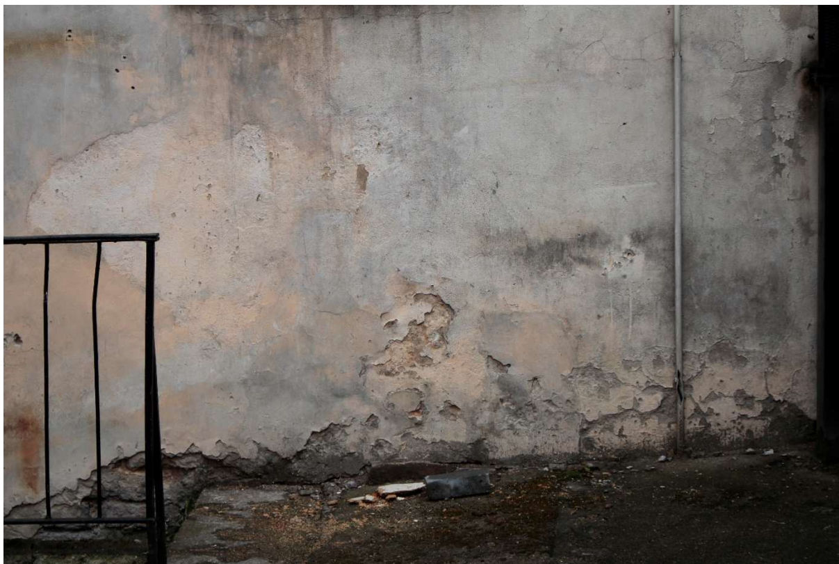
Fot.31. Dom Eskenów, ulica Ciasna 6. W piwnicy budynku znajduje się kotłownia CO. Głęboka, odkryta klatka schodowa jest podczas deszczu zalewana wodą opadową. Zarówno ściany zewnętrzne jak i wewnętrzne noszą ślady korozji chemicznej w postaci spęcherzeń, złuszczeń i wykwitów solnych.
