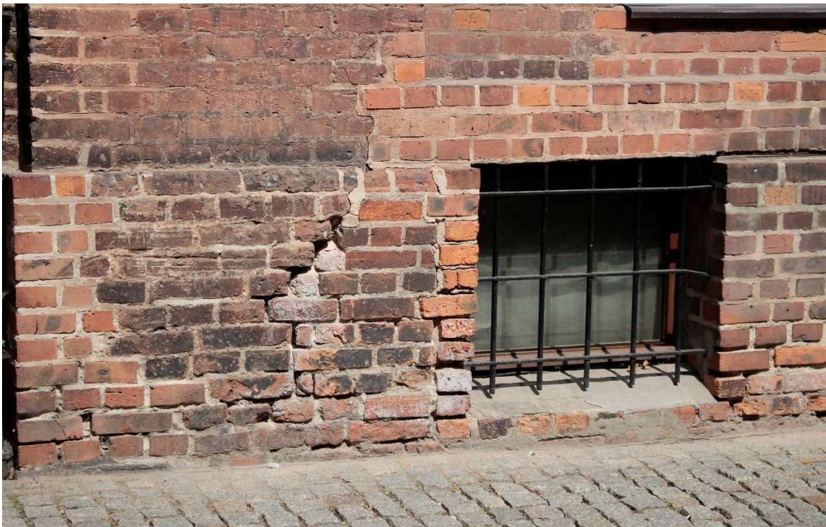
Fot.17. Dom Eskenów, ulica Ciasna, segment C. Na granicy wątków historycznych oraz współczesnych napraw bardzo często występują spękania spowodowane niedostatecznym przewiązaniem muru.
