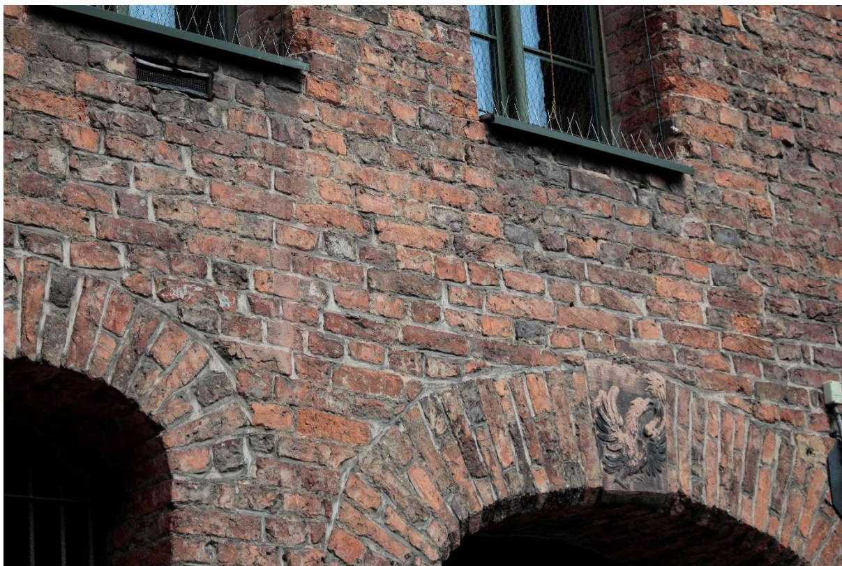
Fot.25. Dom Eskenów, ulica Ciasna 6. Cegła historyczna chociaż zachowana całkiem dobrze posiada mocno rozwiniętą w wyniku wietrzenia powierzchnię. Pokrywają ją intensywna, ciemna patyna.
