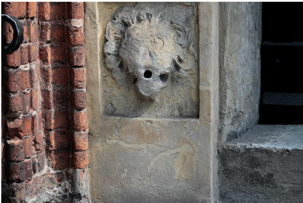
Fot.7. Dom Eskenów, Łazienna 16. Kamieniarka portalu jest mocno zniszczona w dolnej części, detal jest wypłukany i złuszczony.
