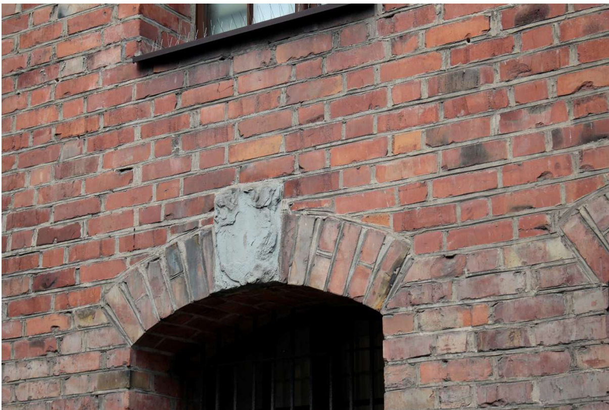
Fot.23. Dom Eskenów, ulica Ciasna 8. Nowej cegły we współcześnie przemurowywanych partiach towarzyszy silna szczelna spoina z podcięciem. Tym samym materiałem „poprawiono” także historyczne partie muru. Uwagę na zdjęciu zwraca także zachowany szczątkowo detale kamienny.
