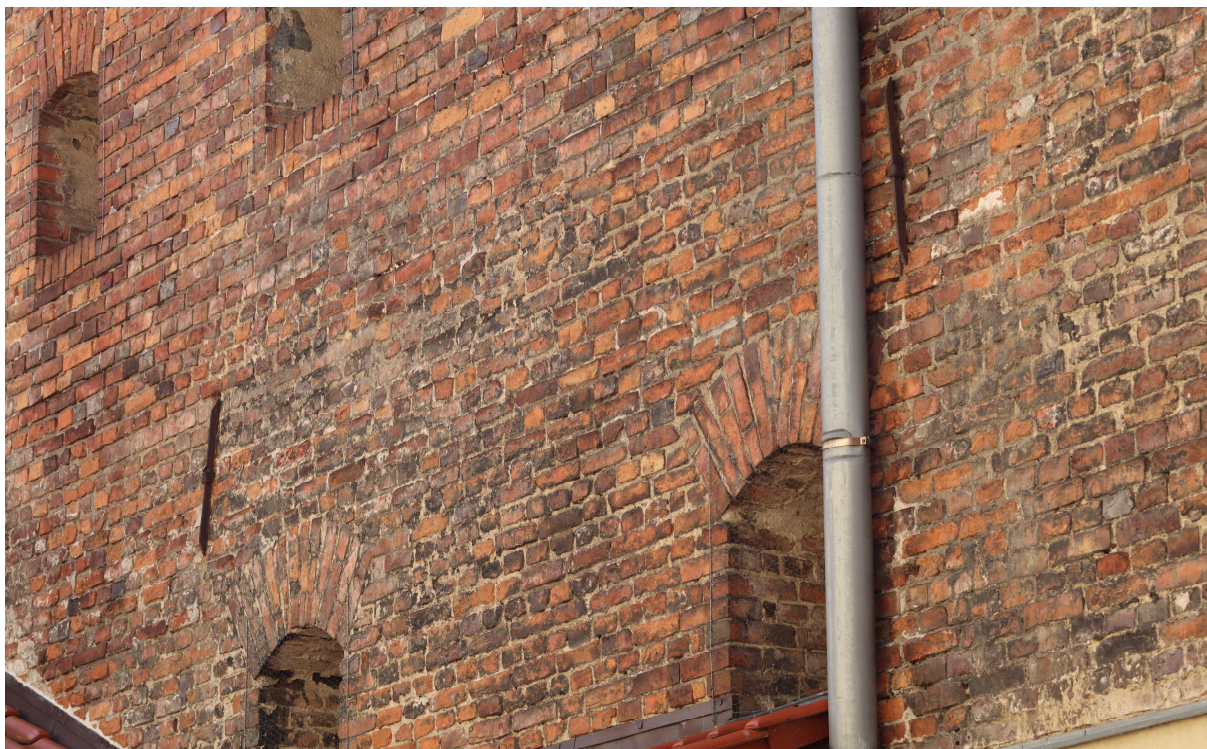
Fot.21 . Dom Eskenów, ulica Łazienka 16 widok na elewację północną. Podobnie jak na pozostałych elewacjach także i na tej, dzięki zachowanej czytelności wątków historycznych, dokonać można jej chronologicznego rozwarstwienia.
