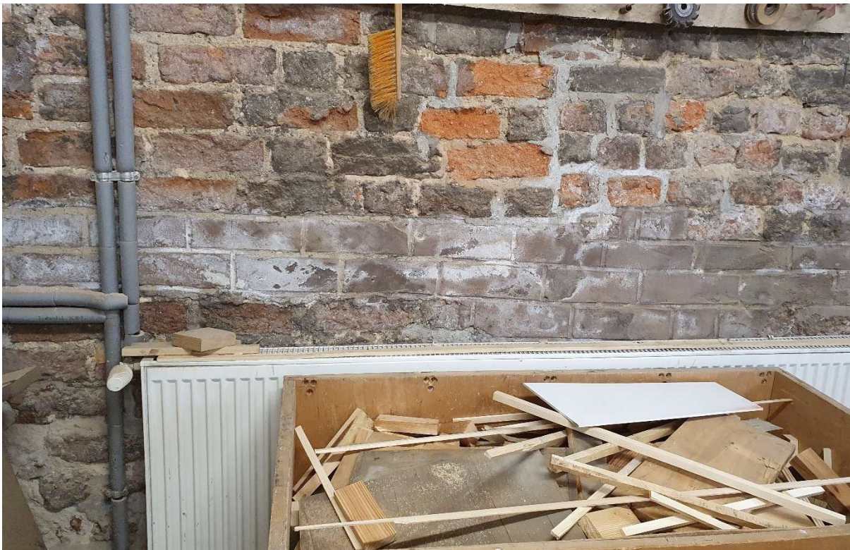
Fot.35. Dom Eskenów, ulica Ciasna, stolarnia. Na ścianach widoczne są zabielenia oraz złuszczenia lica cegły charakterystyczne dla korozji solnej.
