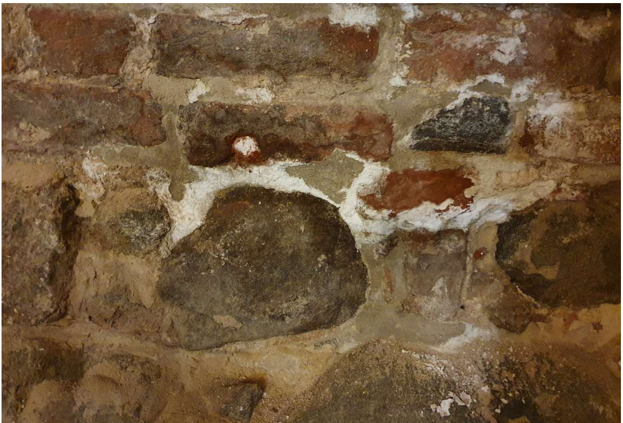
Fot.34. Dom Eskenów, ulica Łazienna 16. W podziemiach budynku obserwuje się obfite wykwyty solne.
