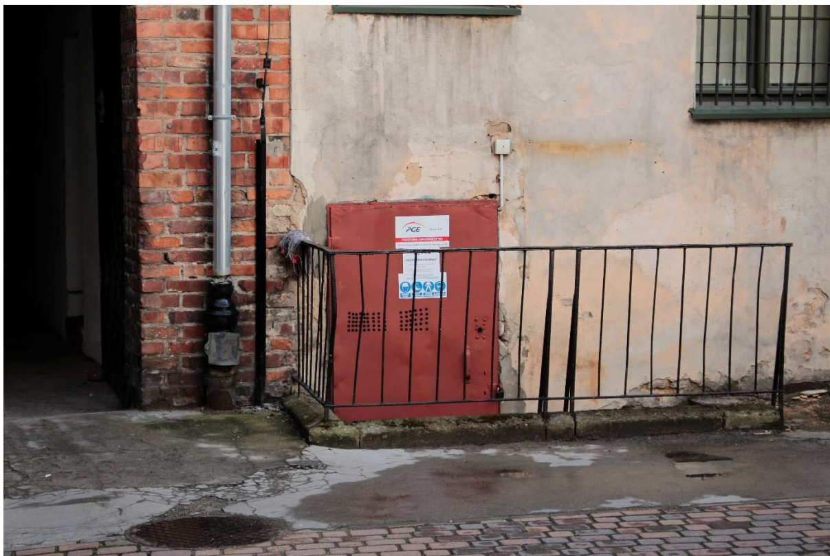
Fot.30. Dom Eskenów, ulica Ciasna 6. W piwnicy budynku znajduje się kotłownia CO. Głęboka, odkryta klatka schodowa jest podczas deszczu zalewana wodą opadową. Zarówno ściany zewnętrzne jak i wewnętrzne noszą ślady korozji chemicznej w postaci spęcherzeń, złuszczeń i wykwitów solnych.
