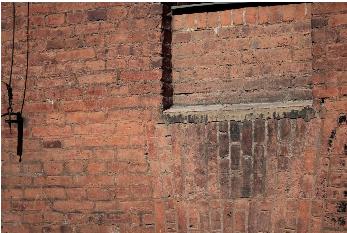
Fot.16. Dom Eskenów, ulica Ciasna, segment B. Połączenie parapetów nisz z murem wykończono w nieprawidłowy sposób. Zaprawa odspaja się od podłoża.
