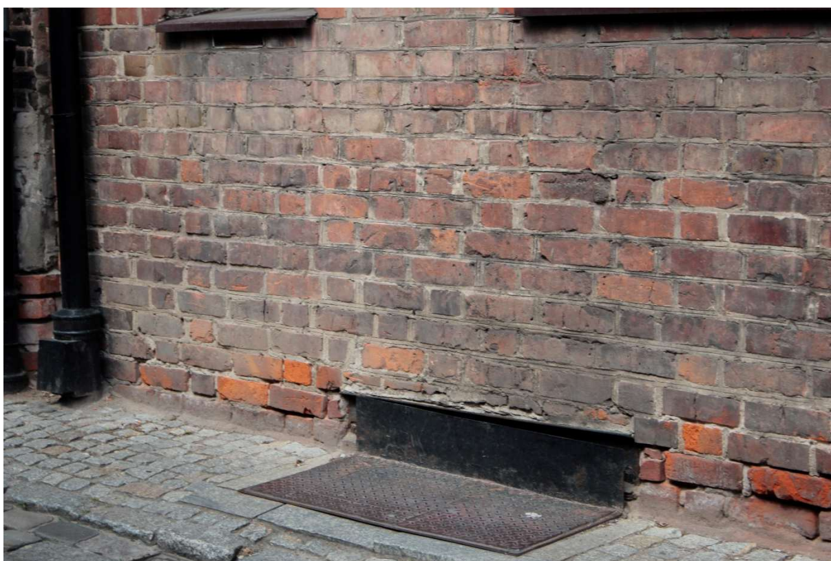
Fot.22. Dom Eskenów, ulica Ciasna 8. Kesony okien piwnicznych zabezpieczono pełnymi płytami z ryflowanej blachy, które utrudniają cyrkulację powietrza.
